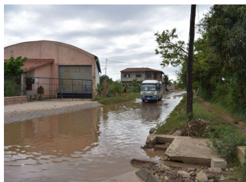
Imagen N° 2: Viviendas afectadas por inundaciones
